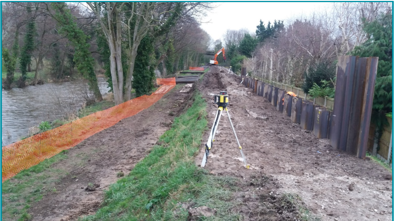
Ffigur 8 – bu'n rhaid gwaredu nifer o goed ar hyd y coridor afon er mwyn i beiriannau ddod i mewn i ddechrau'r gwaith i godi'r amddiffynfeydd presennol
